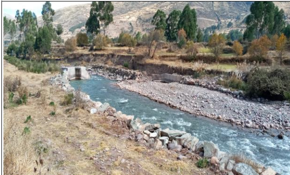
FOTO 01: Se aprecia el curso del agua, del río Pitumarca con pendiente fuerte se aprecia afectado la bocatomina y el canal de irrigación Checacupe.
