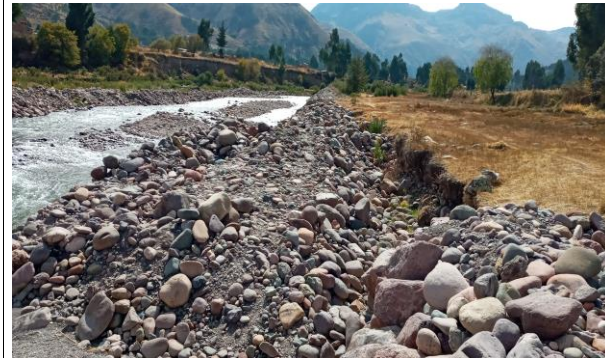
FOTO 03: Talud natural ribera afectada, requiriendo, la limpieza y descolmatación para evitar la erosión.
